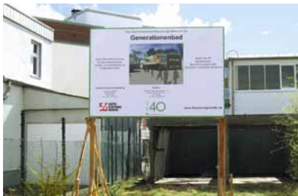
Bauschild: Hier entsteht ein Generationenbad
