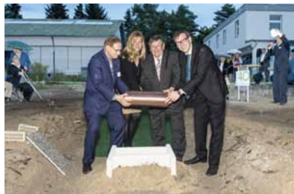
Generationenbad: Am 17.9. erfolgte die Grundsteinlegung.
