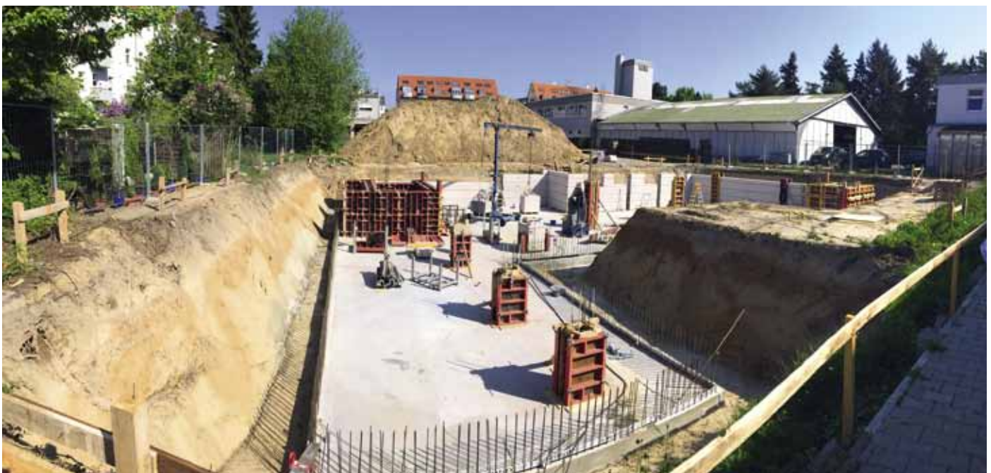
Baustelle Generationenbad am 11.5.16.
