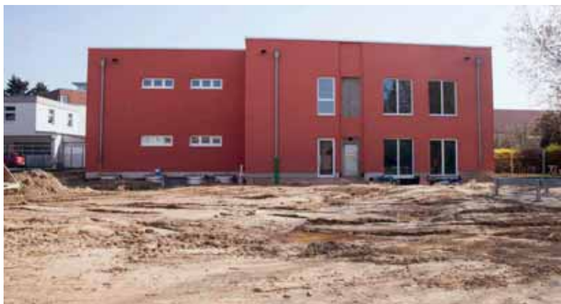
Blick auf das Generationenbad von der Reißbeckstraße am 1.4.17.
